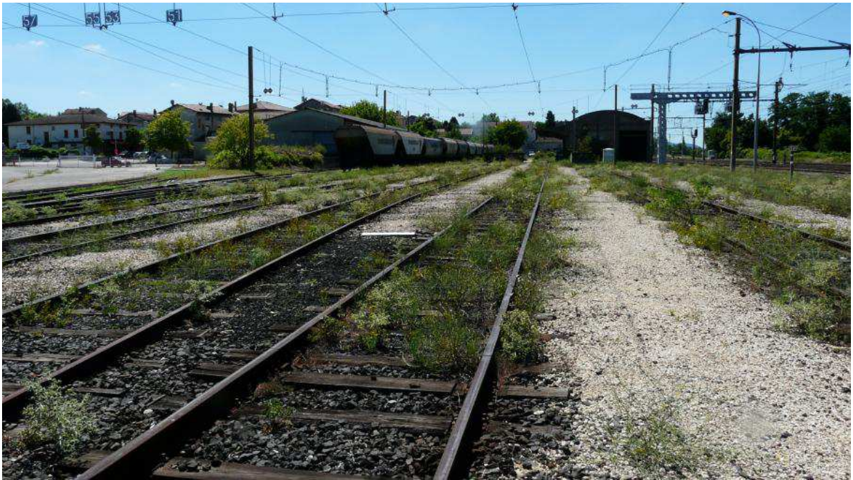
Les voies de service de la gare de Saint-Rambert-d'Albon, dans la Drôme. ( FRANCE 3 )
